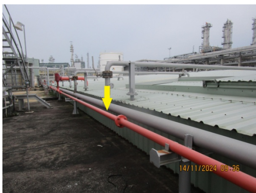
รูปที่ 31 ท่อรวบรวมไอไฮโดรคาร์บอนจาก Holding Basin ไปยัง Vapor Adsorber
