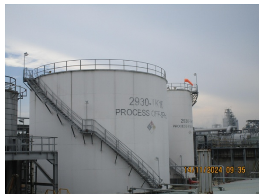
รูปที่ 26 ถังรวบรวมน้ำมันเปื้อนน้ำมันจาก กระบวนการผลิต (OWS) (2930-TK15, 2930-TK16)
