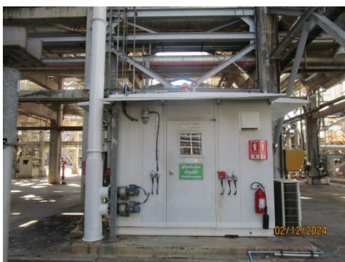
รูปที่ 2 อุปกรณ์ตรวจวัดการระบาย สารมลพิษจากปล่องอัดโนมัต (CEMs)
