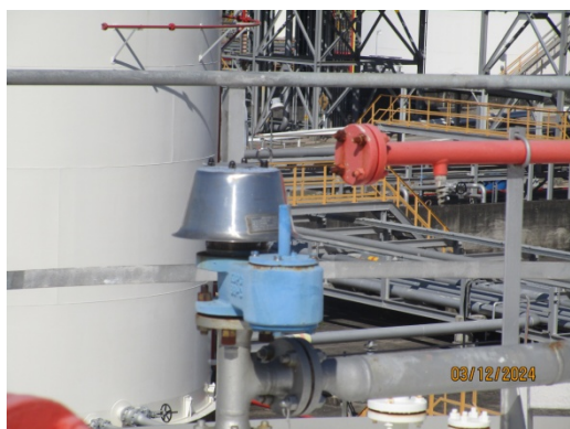
รูปที่ 7 Breather Valve และท่อต่อเข้า VRU
