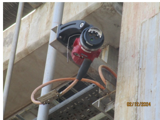
รูปที่ 52 Flame Detector
