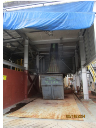
รูปที่ 95 หน่วยกำจัดกากตะกอนจากหน่วยบำบัดปรอท (Sludge Condition No.2)
