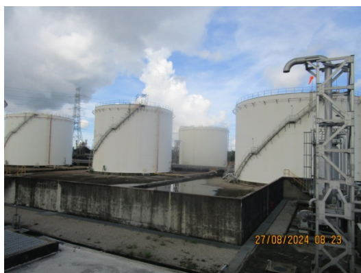
รูปที่ 71 กำแพง (Dike) ล้อมรอบถังเก็บวัตถุดิบและผลิตภัณฑ์
