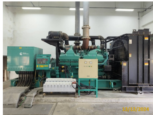
รูปที่ 74 ระบบไฟฟ้าสำรอง (Diesel Generator)
