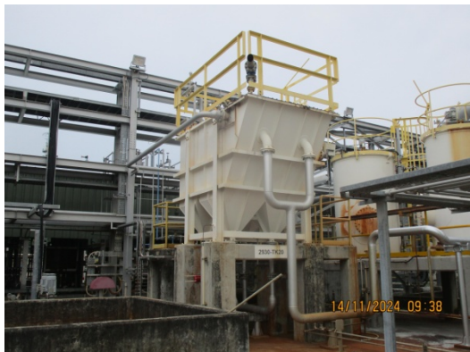
รูปที่ 23 หน่วยแยกน้ำออกจากน้ำมัน (CPI) (2930-TK20) ของ New ETP
