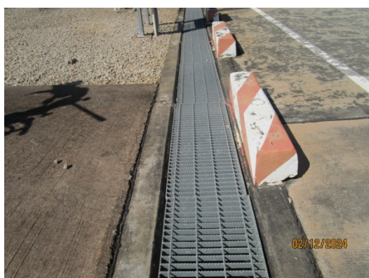
รูปที่ 13 ระบบรวบรวมน้ำไม่ปนเปื้อน (Clean Water Sewer : CWS)
