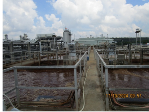
รูปที่ 18 ระบบบำบัดน้ำเสียรวมของโรงงาน แบบ Activated Sludge
