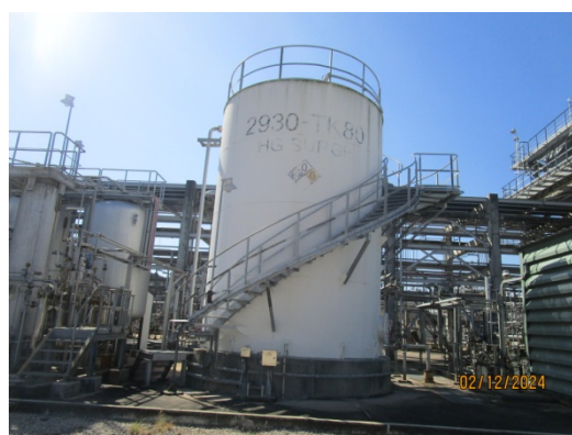
รูปที่ 16 ถังพักน้ำทิ้งปนเปื้อนปรอท (2930-TK80)
