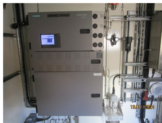
รูปที่ 10 เครื่องมือตรวจวัด THC Analyzer ที่ปล่อยระบายอากาศของ VRU
