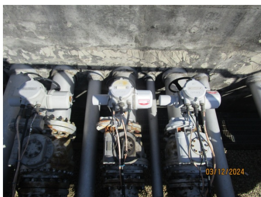
รูปที่ 89 วาล์วตัดแยกระบบ (Isolate Valve) ปลายทาง
