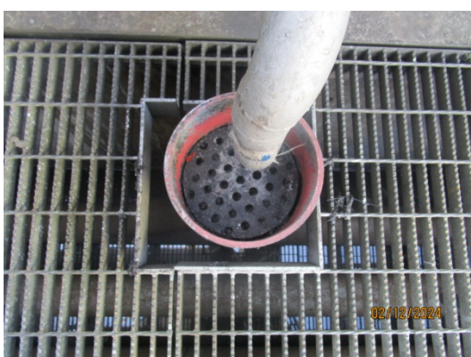
รูปที่ 15 ระบบระบายน้ำเสียจากกระบวนการผลิต ที่ปนเปื้อนน้ำมัน (Oil Water Sewer : OWS)
