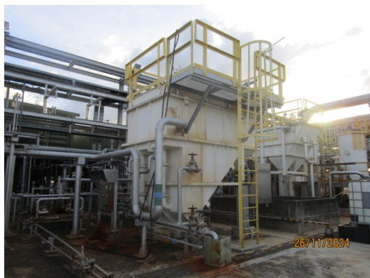
รูปที่ 25 หน่วยกำจัดสารแขวนลอย (DAF) (2930-TK23) ของ NEW ETP
