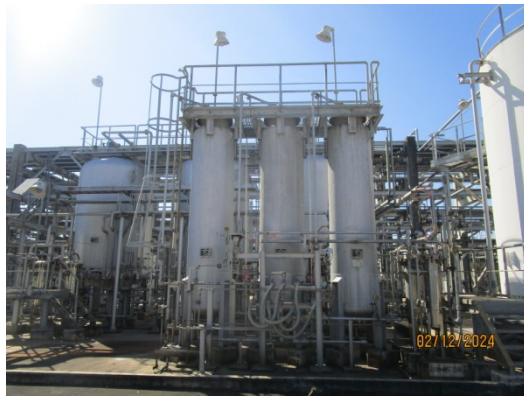
รูปที่ 20 Hg Treating Package สำหรับบำบัด น้ำปนเปื้อนปรอทจากถังเก็บฟลูออรีนจั่นคอนเดนเสท
