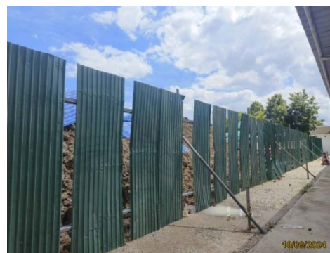
รูปที่ 4 กำแพงกันเสียงบริเวณก่อสร้าง
