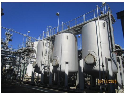
รูปที่ 27 Hg Adsorbent Filter สำหรับบำบัดน้ำเสีย ปนเปื้อนปรอทจากกระบวนการผลิต (น้ำจาก SWS)
