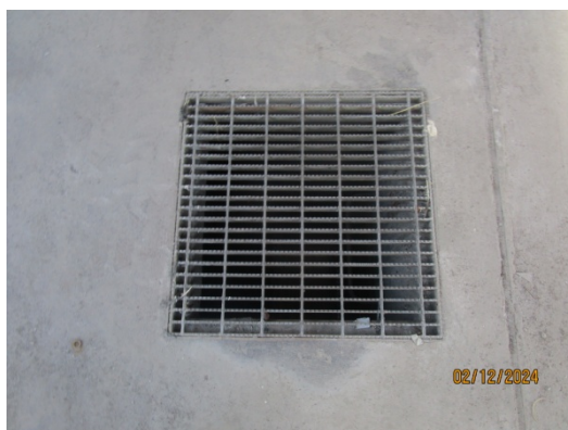
รูปที่ 14 ระบบระบายน้ำที่อาจปนเปื้อนน้ำมัน (Potential Oil Contaminated Water Sewer : POC)
