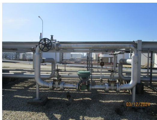
รูปที่ 88 วาล์วตัดแยกระบบ (Isolate Valve) ต้นทาง
