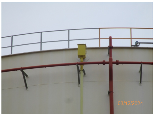
รูปที่ 81 Foam Chamber
