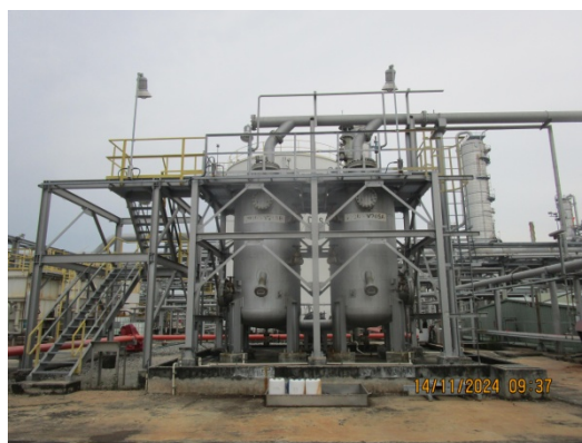
รูปที่ 32 ระบบบำบัดไอไฮโดรคาร์บอนจาก Holding Basin (Vapor Adsorber (2930-V205A/B))
