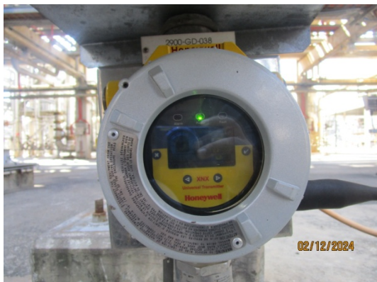
รูปที่ 53 Gas Detector
