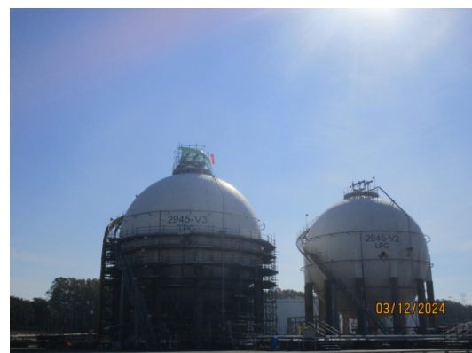
รูปที่ 72 ถังทรงกลมสำหรับเก็บ LPG
